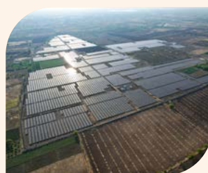
Atharga, Karnataka (KA-3) – 75 MWp Solar Park
