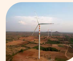
Kudligi, Karnataka (ISTS) (KA-6) – 563 MW Wind Solar Hybrid Park
